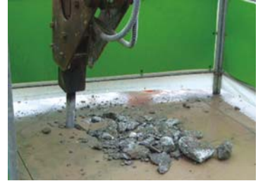
コンクリートスラブ掘削
