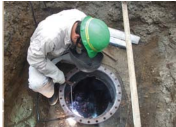
マンホール設置
