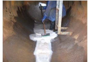
タンク内部洗浄清掃
