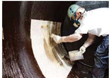
プライマー（地下処理）塗布
